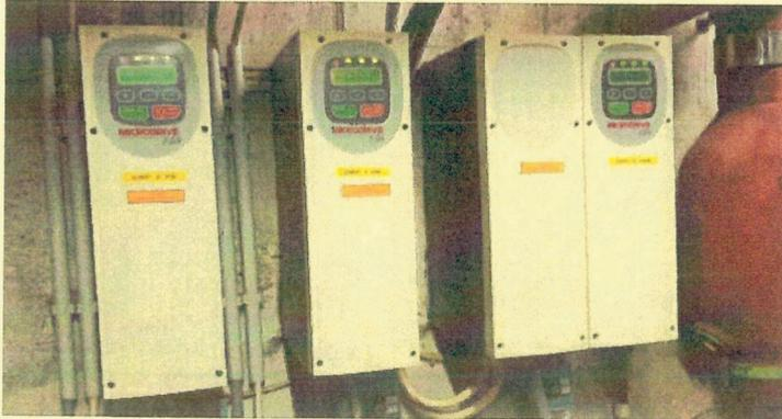
Erwähnenswert sind hier noch die Umwälz-/Druckpumpen zu der Attraktionsrutsche im großen Nichtschwimmerbecken. Diese Pumpen werden im Betrieb nur „Ein- und Ausgeschaltet“ und verfügen über keinen Frequenzumformer (FU). Das bedeutet, diese Pumpen „verbrennen“ bei jedem Betriebstag Energie. Auch die Steuerung dieser Pumpen, muss manuell durchgeführt werden. Diese Situation sollte umgehend separat begutachtet werden.
