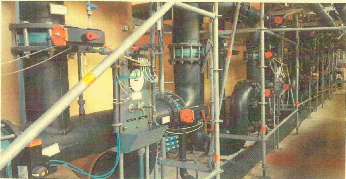
Mit zunehmender Filterbetriebsdauer sammelt sich der Schmutz im Filterbehälter an, der spätestens nach 72 Betriebsstunden aus dem Filter gespült werden muss. Damit der Spülvorgang optimal abläuft und der sich angesammelte Schmutz möglichst rückstandsfrei ausspülen lässt, ist es erforderlich, dass das Spülabwasser drucklos und ohne Rückstau aus dem
