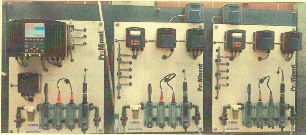
Die Messwasserentnahme erfolgt im Technikhaus und wird über eine Leitung direkt an die Mess.- und Regeltechnikanlage geführt. Diese Messwasserentnahme hat nur den geostatischen Druck der Leitung. Dies führt immer wieder zu Schwankungen am Druck des Messwassers. Dieser Druck muss aber für die Messung der Hygienehilfsparameter immer konstant sein. Abhilfe kann hier nur eine sogenannte Messwasserpumpe schaffen, die sich ohne größere Eingriffe in das vorhandene System implementieren lässt.
