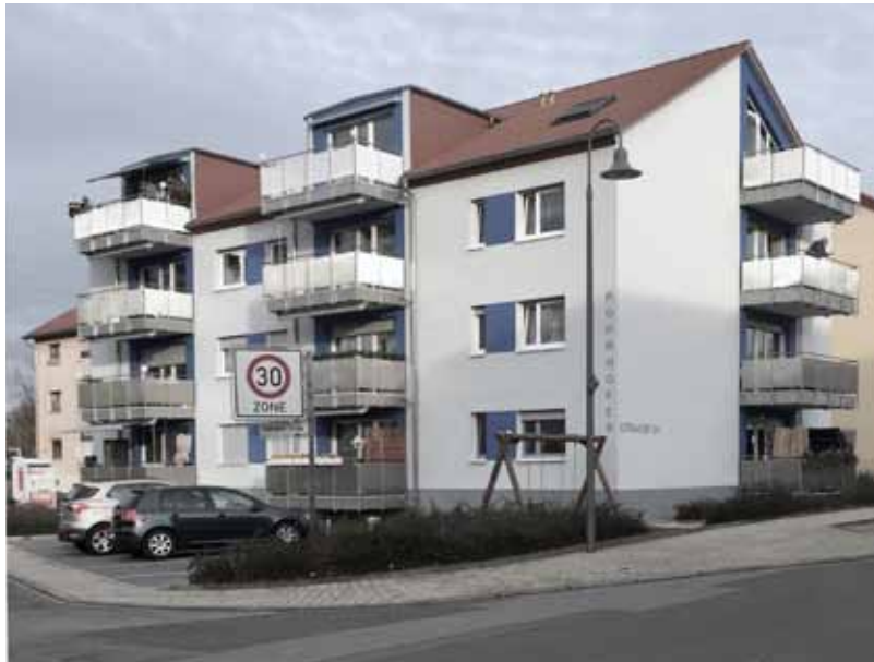
Baugesuch 2013 / Ausschreibungen 2014 / Bau 2015
