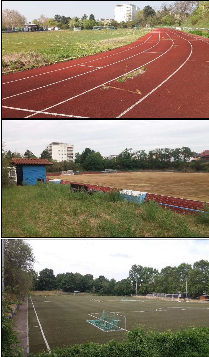
Abb. 2: Ansichten des Untersuchungsgebiets Alfred-Körper-Stadion in Brühl.
