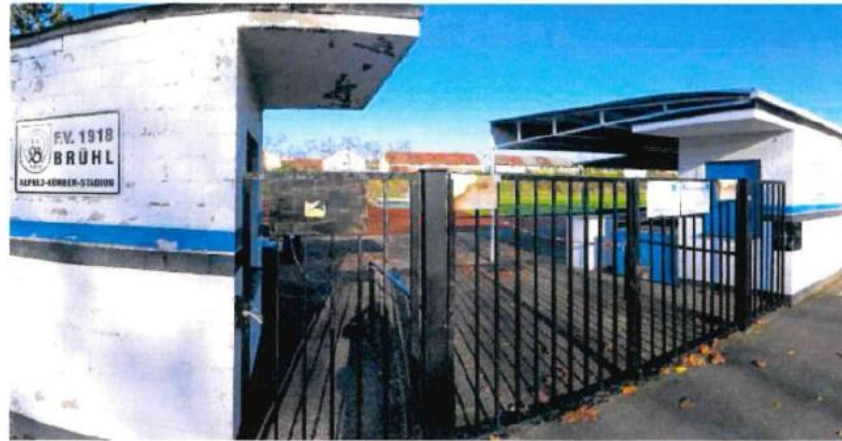
Im nächsten Jahr soll der FVB sein angestammtes Areal mit dem Alfred-Körber-Stadion verlassen. Danach soll dort ein neues Wohnquartier entstehen, dessen Bebauungsplan derzeit öffentlich ausgelegt ist.
